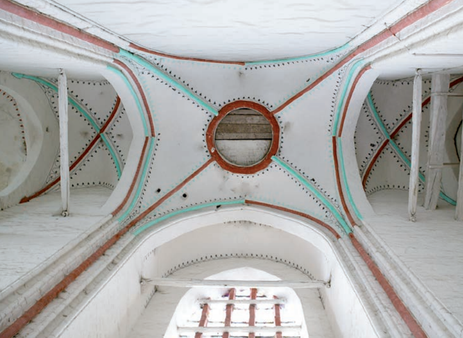
Blick in das Gewölbe der Turmhalle
